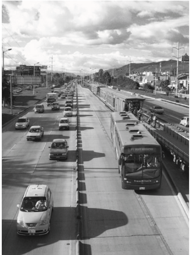
FOTO 2. ESTACIÓN DE TRANSMILENIO EN BOGOTÁ. Es una solución CONTRAINTUITIVA PORQUE DESAFÍA LA PERCEPCIÓN DE LAS LIMITACIONES DEL AUTOBÚS CON RELACIÓN AL METRO.
