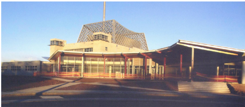
Figura 3. Edificio del reactor OPAL (Australia)
